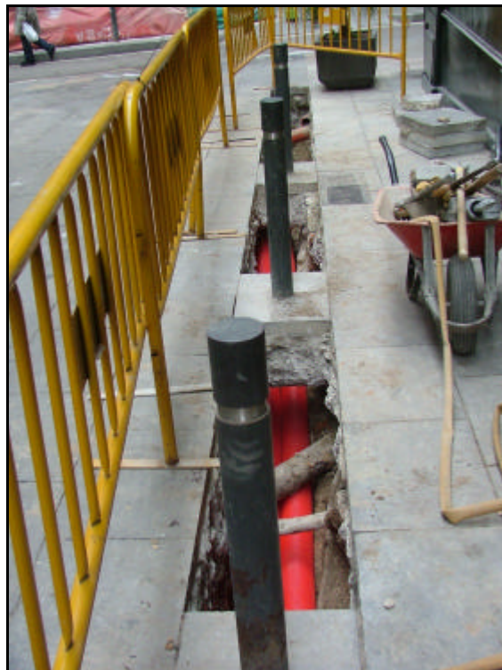
Foto 3.- Vista general de la rasa 1 amb els tubs de canalització dels cables elèctrics.
