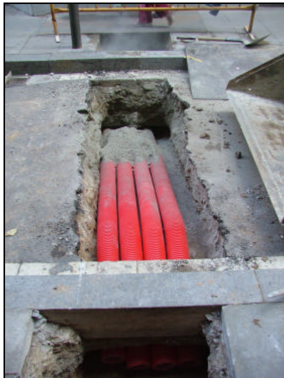
Foto 7.- Vista general de la rasa 4 amb els tubs de canalització dels cables elèctrics.
