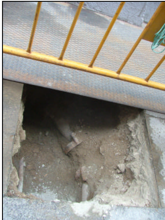
Foto 6.- Vista parcial de la rasa 4.
