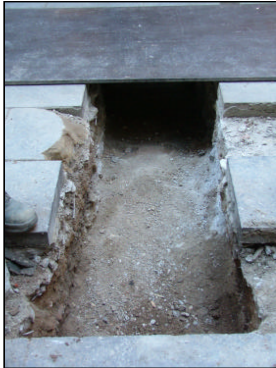
Foto 4.- Vista parcial de la rasa 2.
