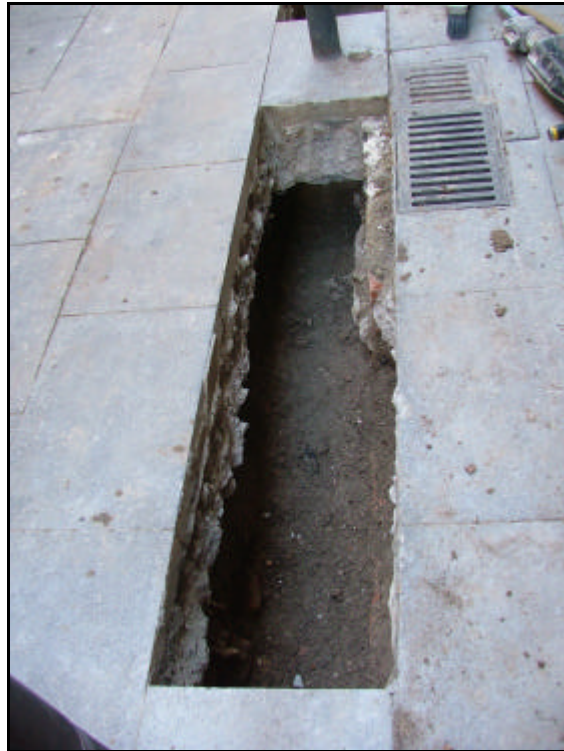
Foto 1.- Vista parcial de la rasa 1.
